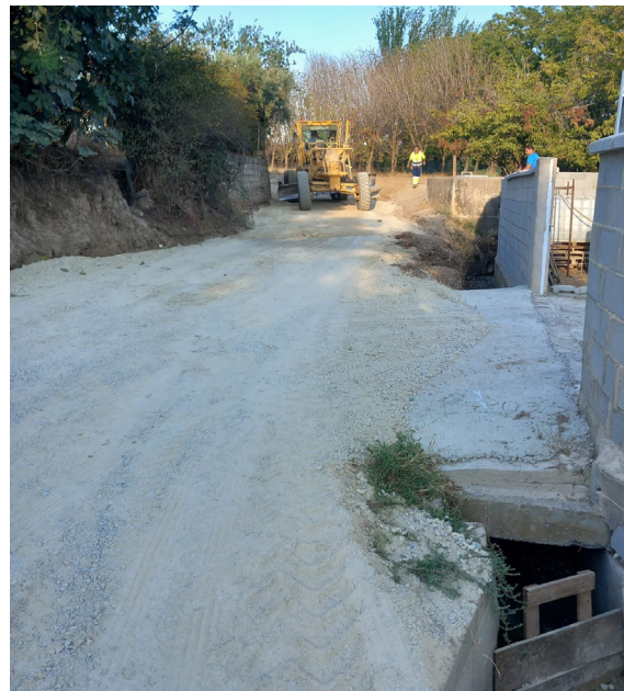
Acondicionamiento de un tramo de ruta.
