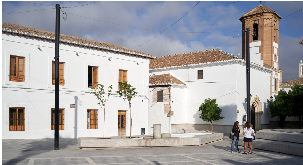
A la izquierda, imagen virtual de la plaza de la Constitución una vez remodelada. A la derecha, obra de mejora del entorno del Molino de los Aragonés.
